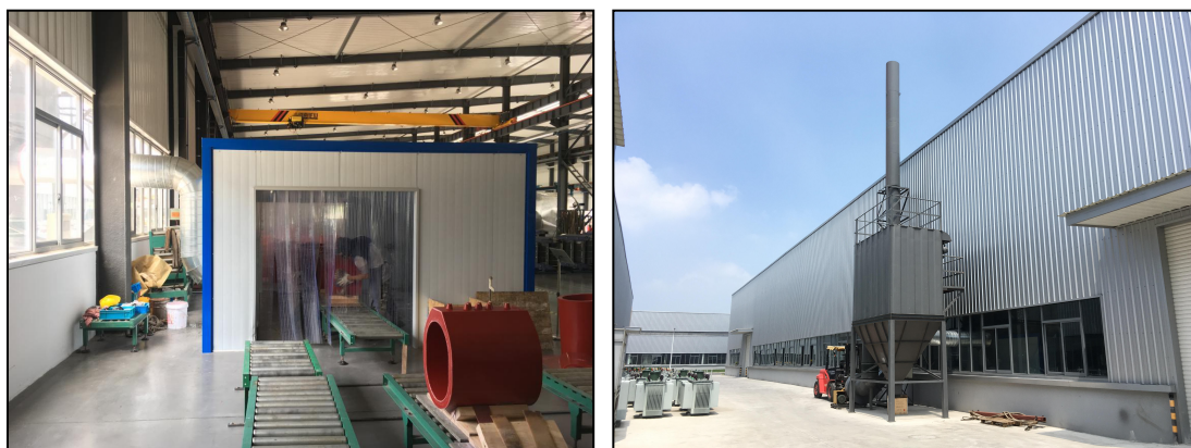
图 4.1-8 线圈打磨粉尘处理系统（室内、室外）
