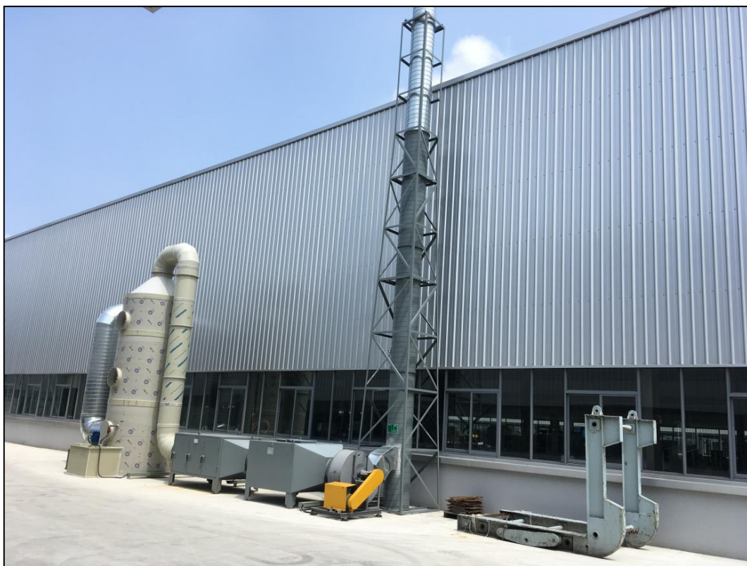
有机废气处理系统（室外）
