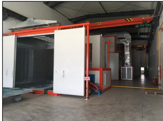
喷漆车间废气收集系统
