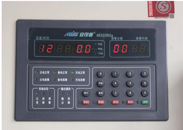
图4.1-11 涂装车间安装可燃气体报警装置
