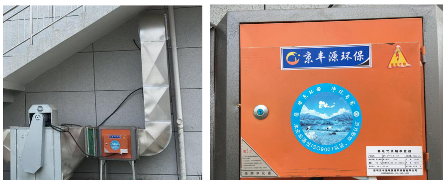
图 4.1-9 食堂油烟净化器现场照片
